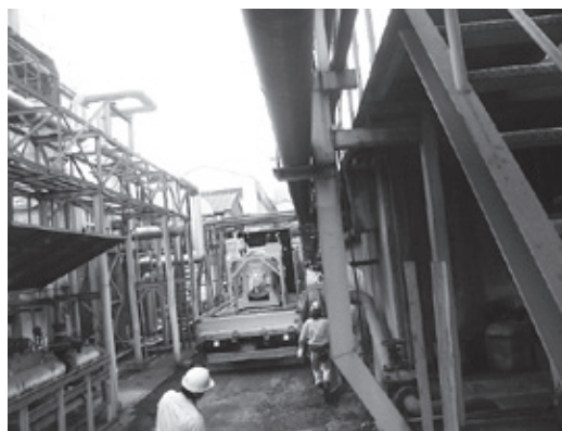
搬入路を改良して通行可能となった15tトラック
