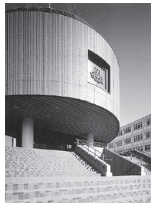
関西大学総合学生会館「メディアパーク凜風館」 815kW×2台のガスコージェネと生ゴミ処理システムを施工した
