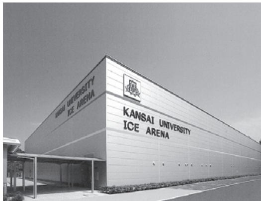
関西大学アイスアリーナ 50kW非常用発電設備を設置した
