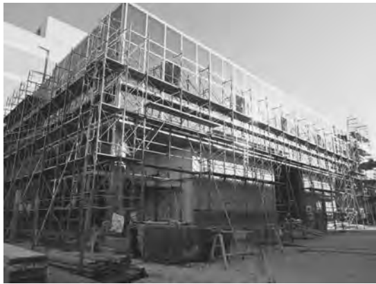
建設中の三友工業の新社屋
