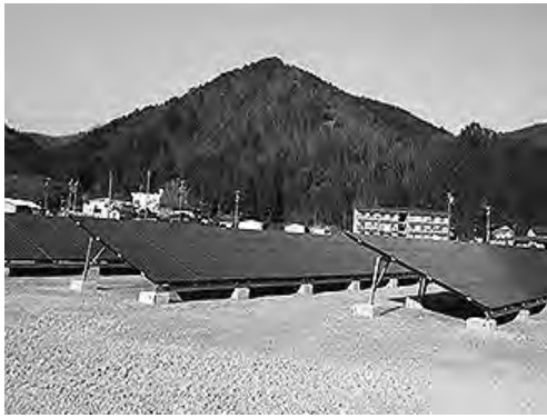
太陽光発電設備設置工事
