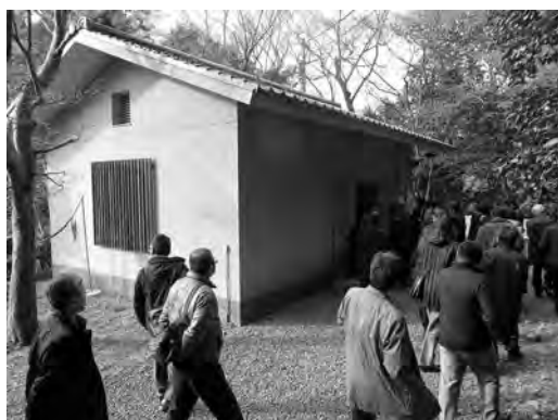
非常動力装置2基が設置されているポンプ施設
