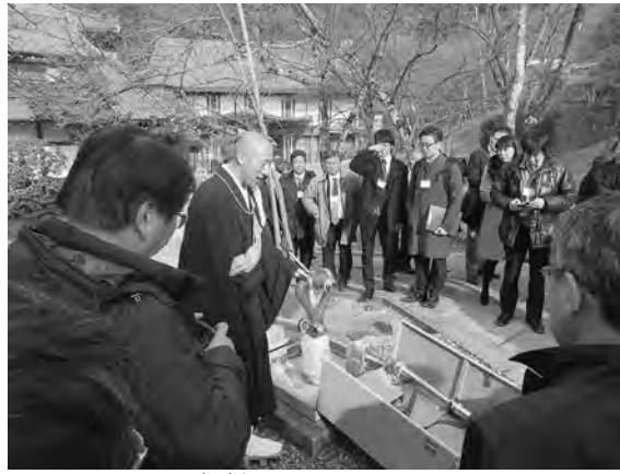
さいもん 西門脇の屋外消火栓
