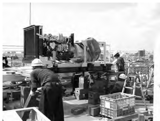
屋上で発電機を組立後、基礎上へ運搬、ボンネット組立
