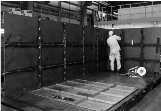
主燃料槽18,000L角タンクの製造中
