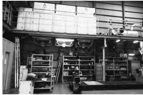
中2階に併設の負荷装置6600V/1,200kW
