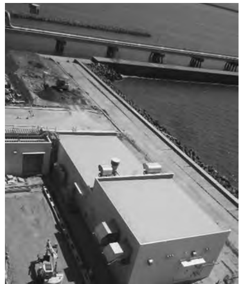
LNG基地の発電設備室から海岸を臨む
