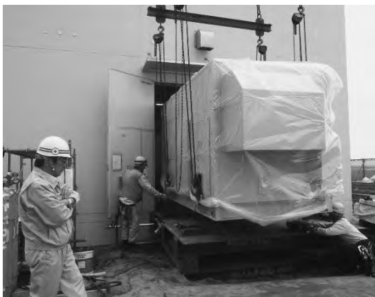
非常用発電設備の搬入を見守る山口さん
