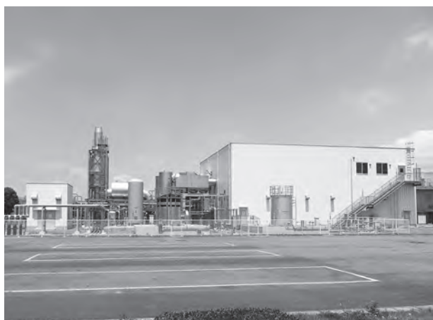
右の白い建物はコージェネがある発電設備室
