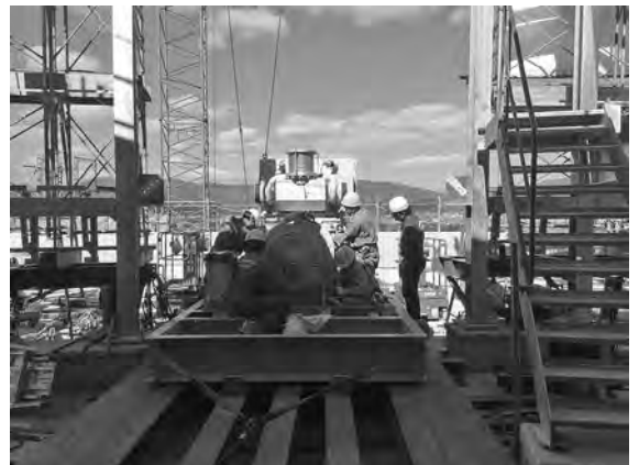
発電設備の搬入光景（奥に見えるのが高松市街）
