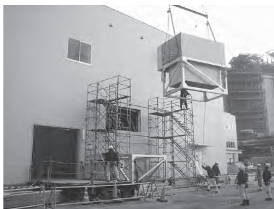
発電設備の揚重作業
