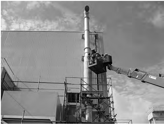
大型煙突の据付光景（平成13年頃）
