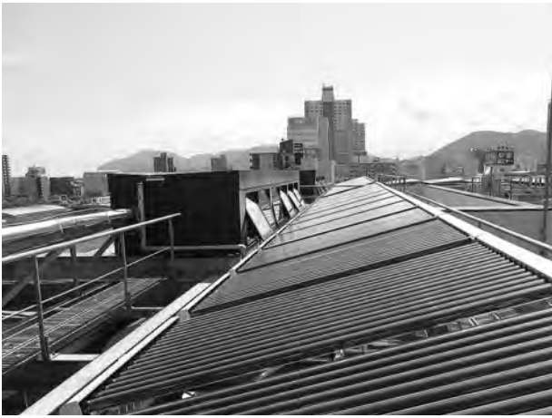
太陽集熱システム（右）と排気窓（左）
