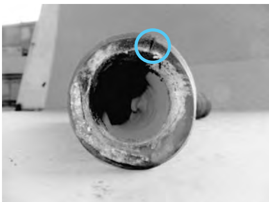
写真4 冷却水ゴムホースの口元の亀裂
