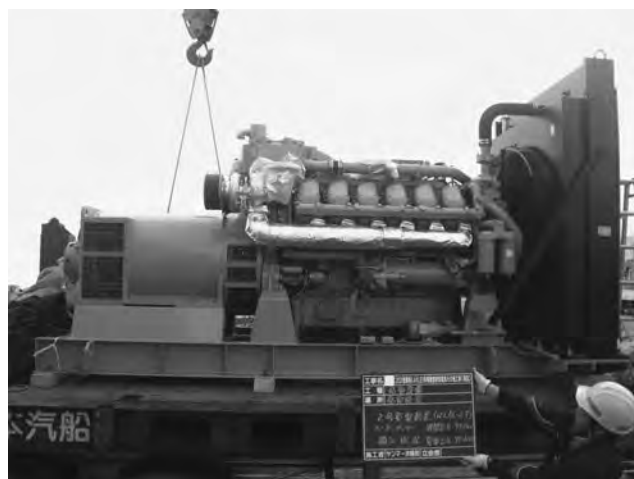
米軍施設向け非常用自家発電装置の揚重及び搬入
