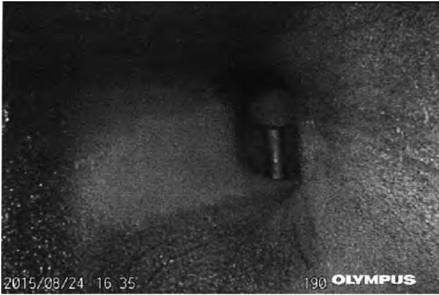
図5 未燃燃料除去試験前の排気ポート内部の状態
