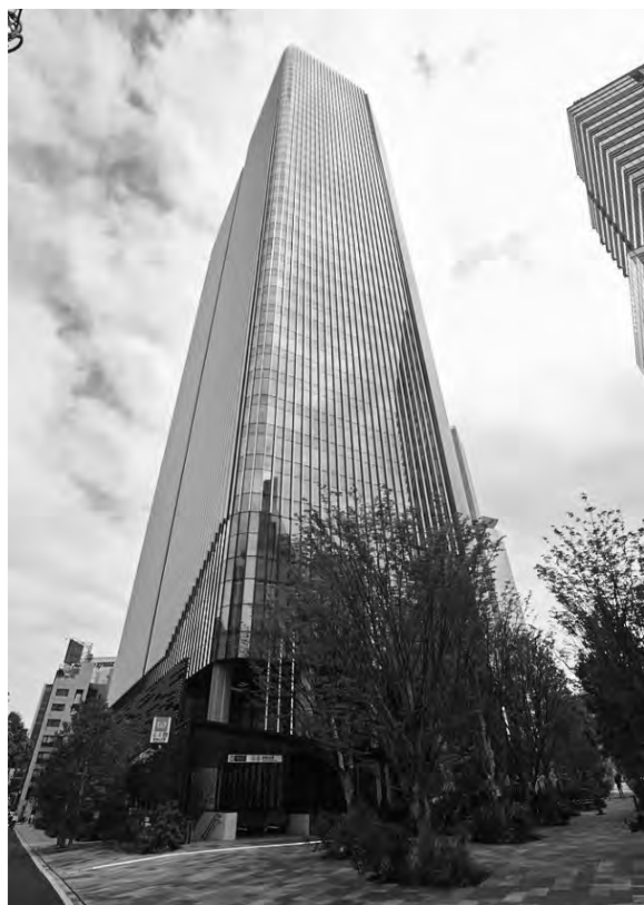
赤坂インターシティAIRの外観
