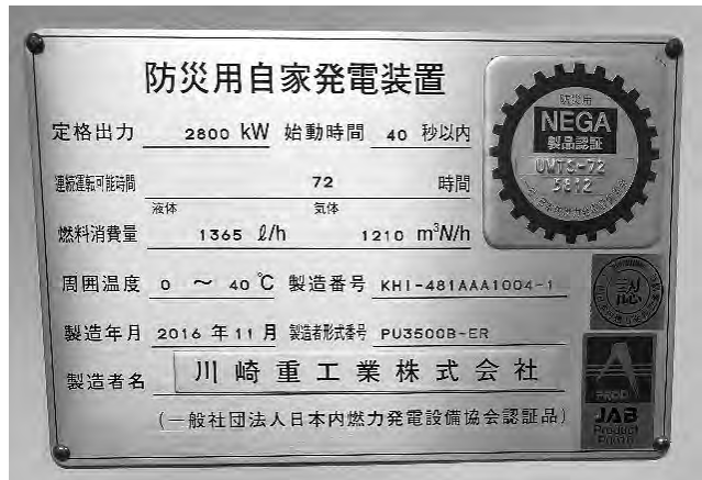
ガスタービンに貼布された内発協の適合マーク
