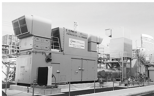
出所：N E D O、ドライ低NO x 水素専焼GTの実証試験プラント
