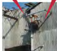
高圧変圧器 高圧コンデンサー
