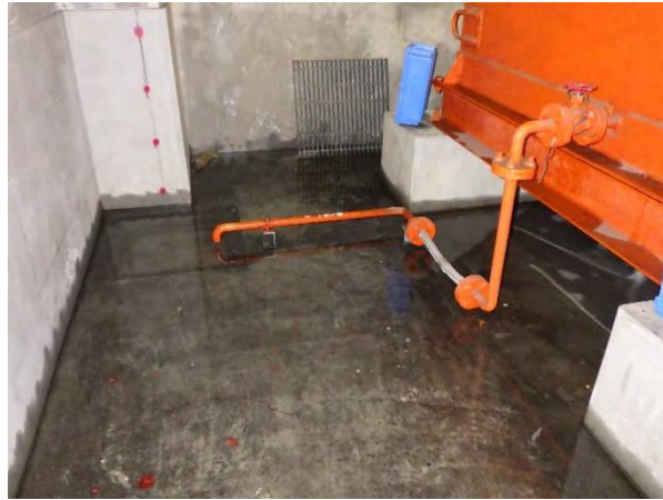
写真 防油堤内の状況
