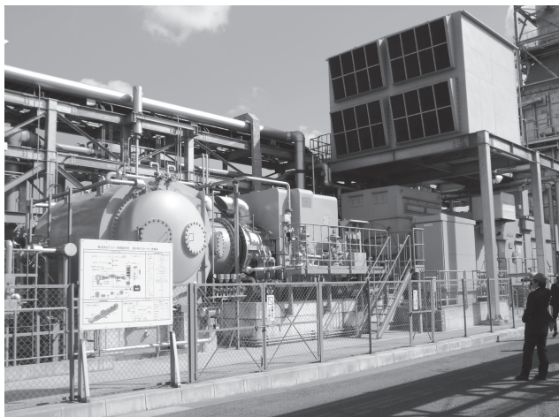
20,000kWの日立製ガスタービンコージェネ
