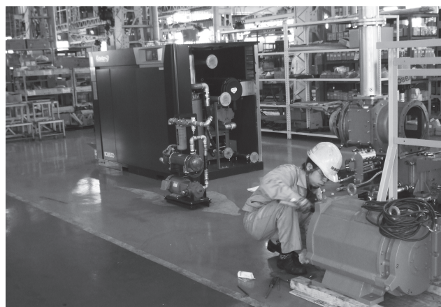
組み立て中の小型蒸気発電機
