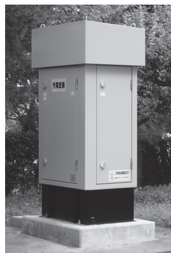
5kVA 空冷ディーゼル非常用発電機
