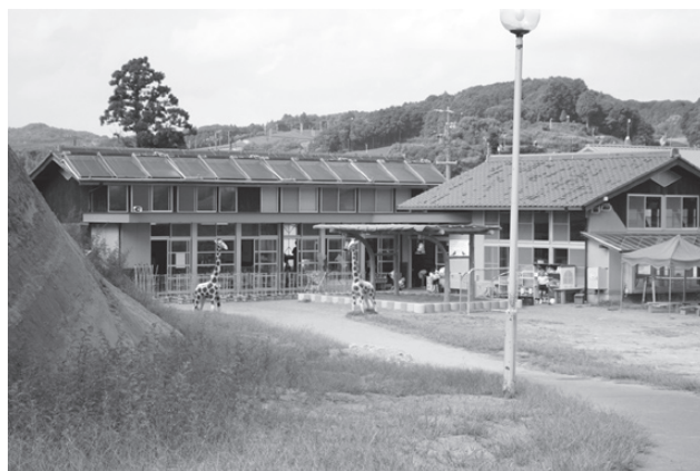
写真7 屋根に設置された太陽熱温水器
