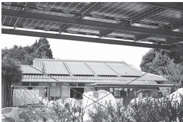
写真2 桜木保育園の太陽光パネル
