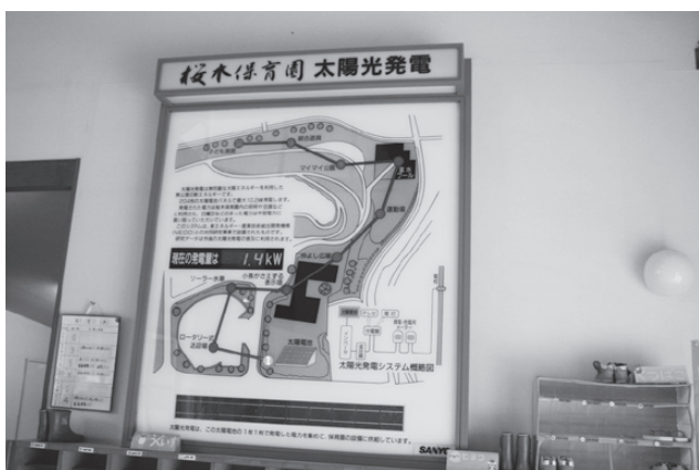
写真4 園舎内の発電量表示器
