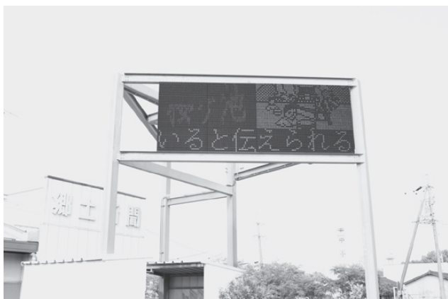
写真9 太陽光発電による電光表示灯
