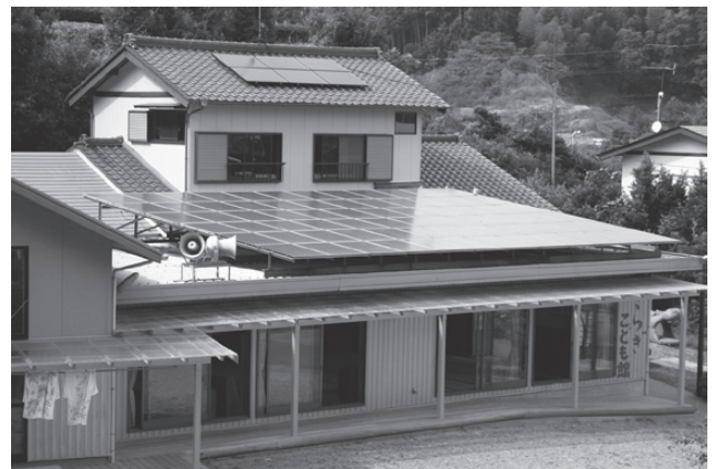
写真1 さくらぎこども館の太陽光パネル
