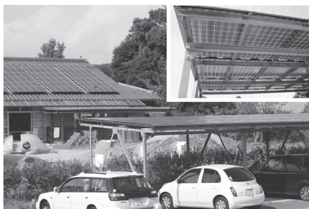
写真5 駐車場屋根の太陽光パネル(右上は屋根の裏側)
