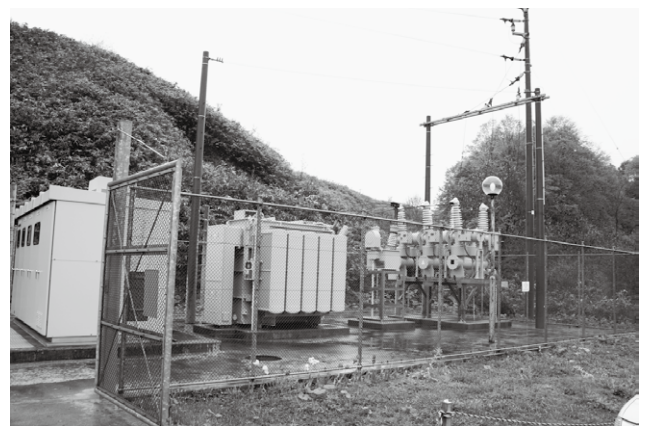
写真2 田代平風力発電所の変電設備
