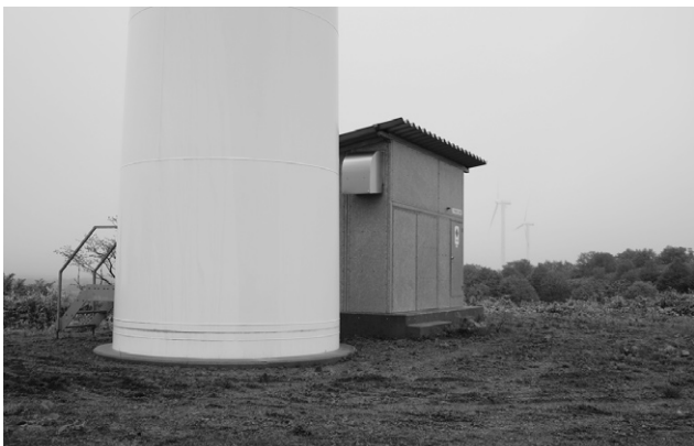
写真4 トランスを収納した小屋
