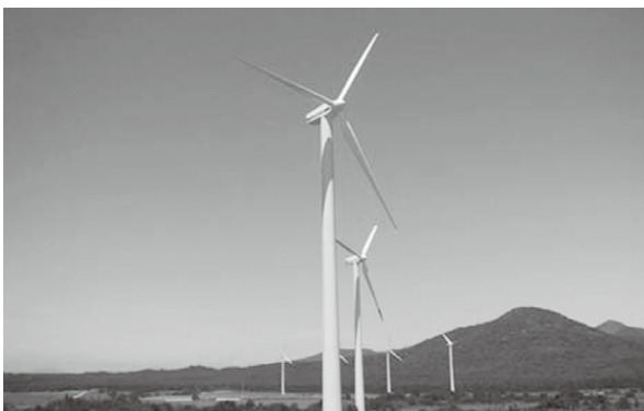
田代平風力発電所
