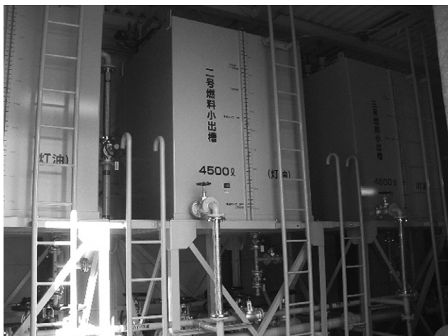
自社開発した4,500ℓの燃料タンク
