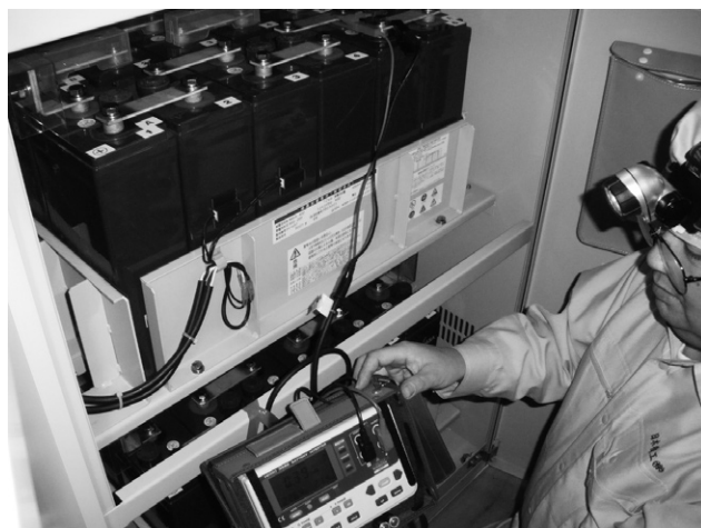
蓄電池の内部抵抗の測定作業
