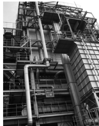
流動層ボイラー
