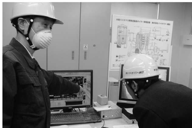
発電所を遠隔監視している中央制御室
