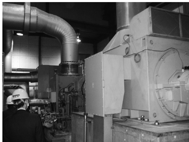
蒸気タービン
