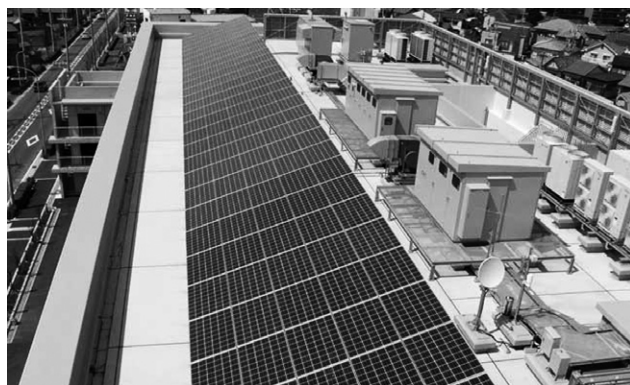
岸和田市消防本部庁舎に納入した太陽光発電設備
