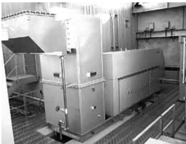
早稲田大学 11 号館に納入した非常用発電設備
