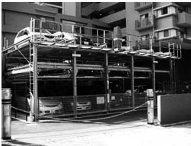
地上 3 段横行昇降式の立体駐車場
