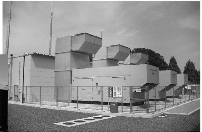
(上) 通信会社のデータセンターに複数台納入された3,000kVAのガスタービン自家発電設備(写真提供：日本機工(株))、(左) 海底地盤改良船の電源で活躍する可搬形発電設備DCA-800SPK(写真提供：デンヨー(株))
