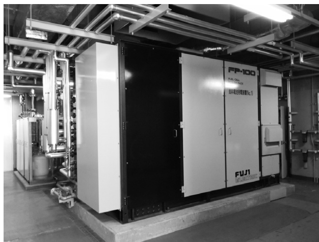
富士電機製100kW リン酸形燃料電池
