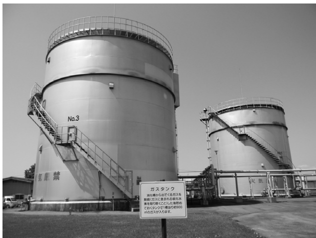
ガスタンク(1槽900m 3 )
