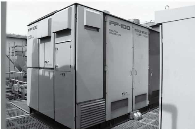
写真1 リン酸形燃料電池設備 (PAFC)
