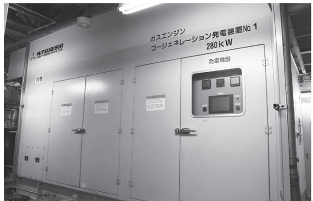
写真2 ガスエンジン発電設備
