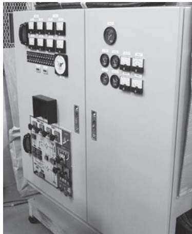
無停電電源装置用発電機操作盤
