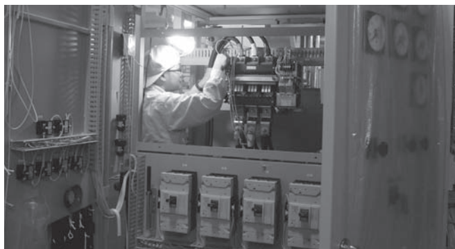
発電機制御盤の組立配線作業
