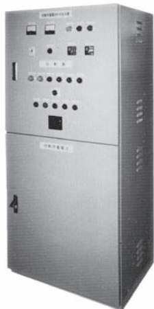
非常動力用自動盤
