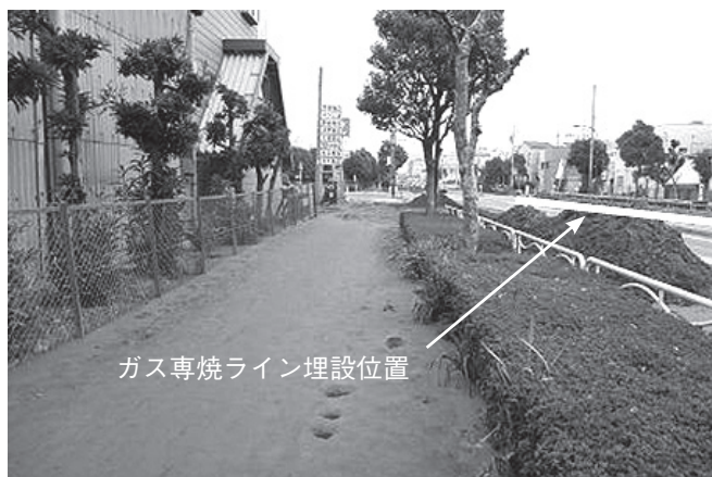
写真3 埋設部の状況写真
