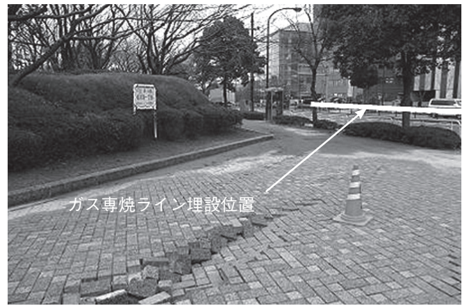
写真2 埋設部の状況写真
