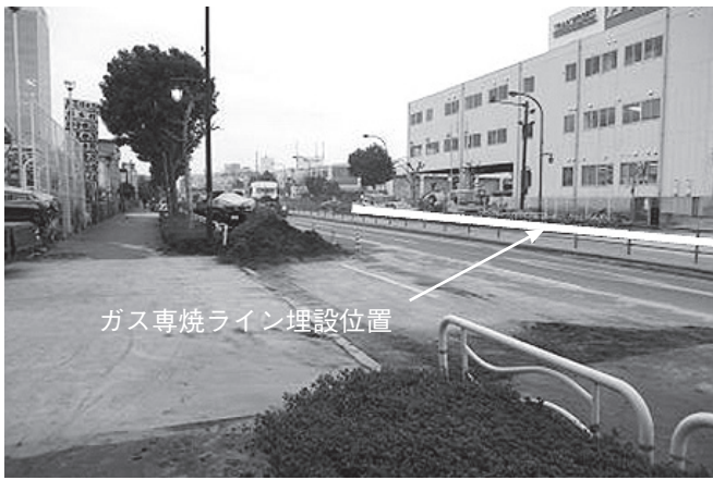
写真1 埋設部の状況写真
