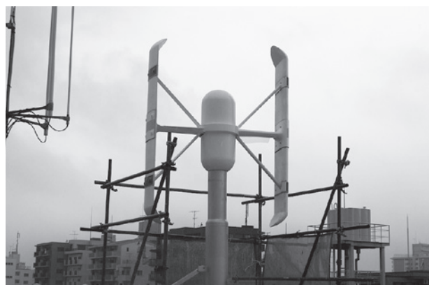
ベルシオン型風力発電設備（3kW）
