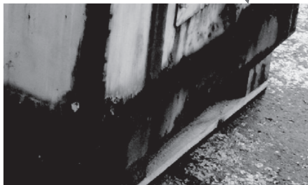
図3 側板部が発錆及び腐食し破孔
