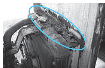
写真5 ラジエータ支台腐食し破孔
