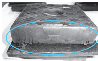
写真27 防振ゴムに亀裂
