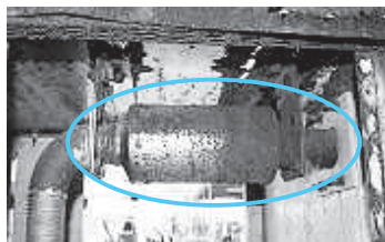
写真2 排気消音器発錆及び腐食
