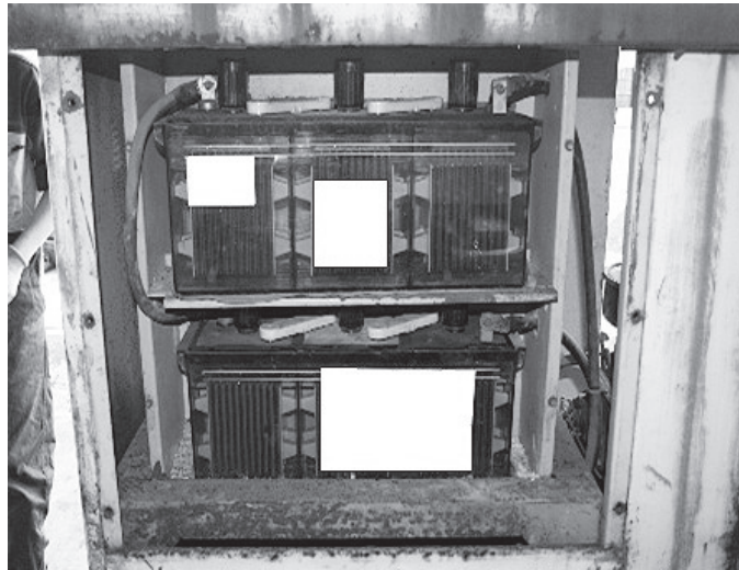
写真7 蓄電池 コンパウンド割れ及び液漏れ
