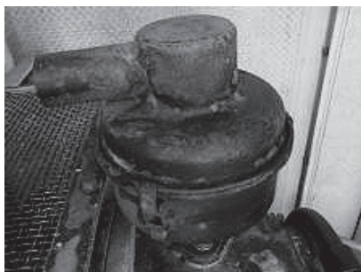
写真23 オイルミストセパレータの汚損と発錆
