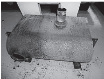
写真13 排気消音器発錆
