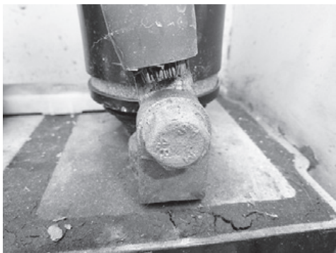
写真9 端子部発錆と蓄電池コンパウンドの割れ
