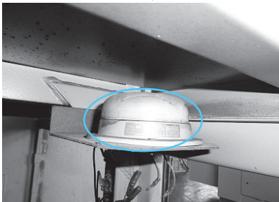
写真12 短絡した警報機
