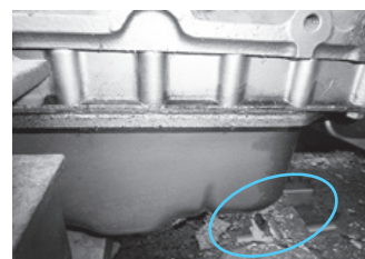
写真5 設備設置台板の破孔
