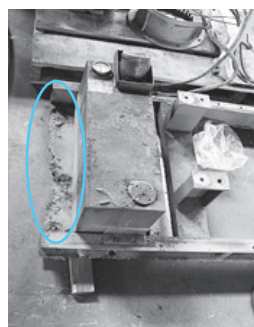
写真4 燃料容器下の敷板の腐食
