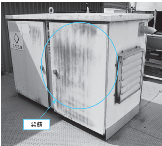
写真1 キュービクル側面の発錆状況
