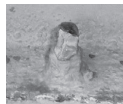
写真3 腐食アンカーボルトの拡大
