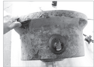
写真17 発電機フレームの発錆
