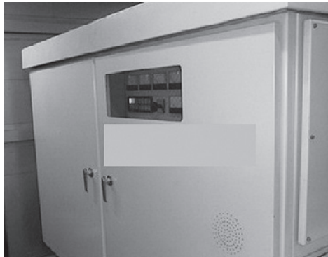
写真1 エンクロージャ正面
