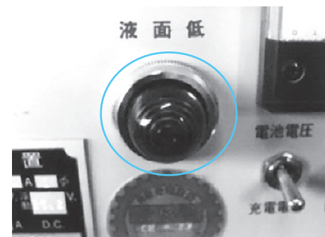
写真17 蓄電池の液面低下表示灯の球切れ有り
