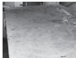
写真3 エンクロージャ天板に若干塵埃の付着有り
