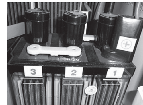
写真19 蓄電池封口部拡大特に異常無し
