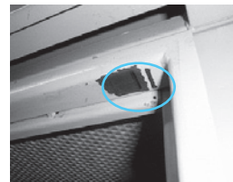
写真5 エンクロージャ扉枠の接触部分に発錆有り
