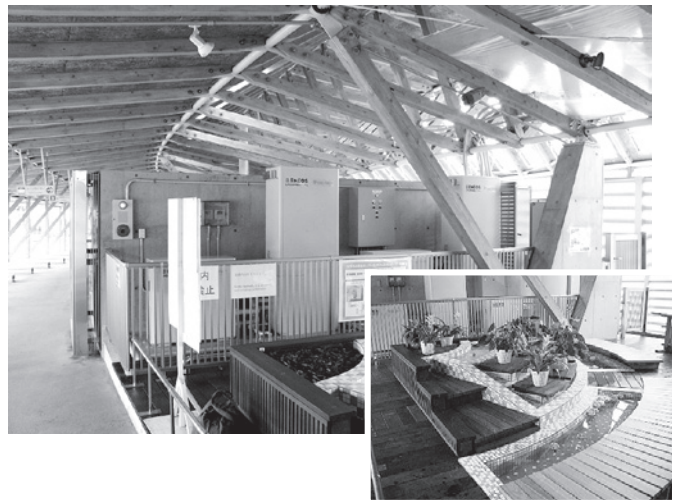
燃料電池2基の廃熱を利用した「足湯」
