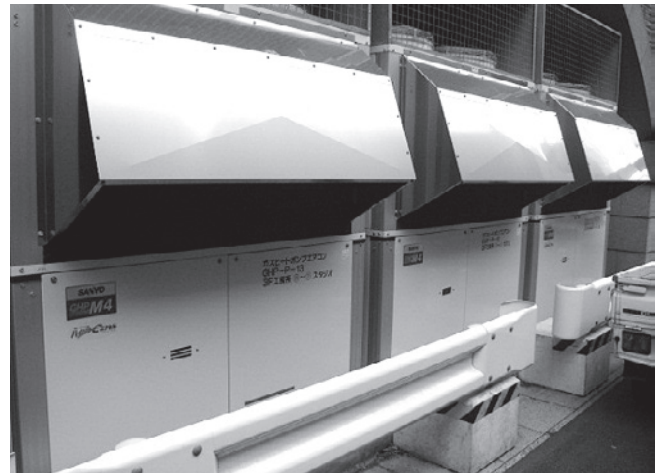
発電機能付きガス式空調機（GHP）
