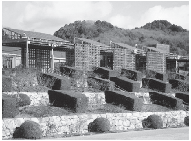
テーマガーデンに設置された太陽光パネル
