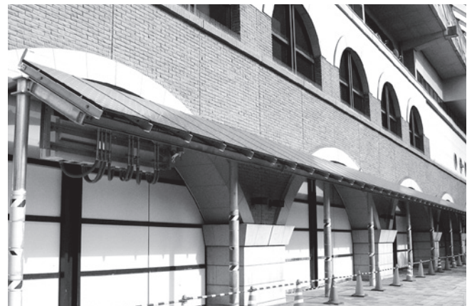
高架下に設置された太陽光パネル
