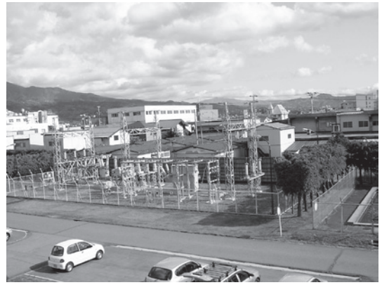
地元民間工場 66kV特別高圧変電所
