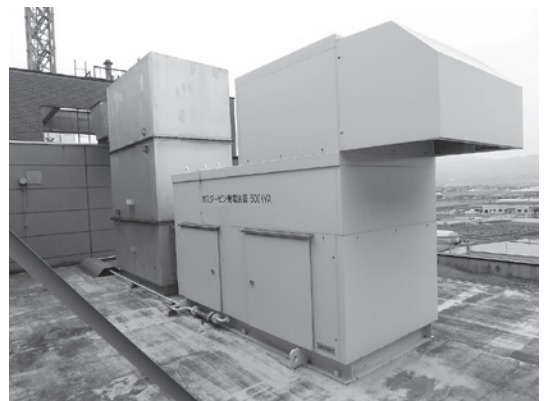
テレビ放送局本社 500kVAガスタービン発電装置
