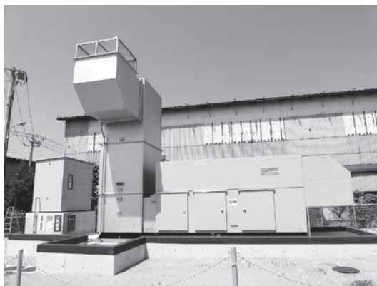
地元紙制作センター 1,500kVA非常用ガスタービン発電装置
