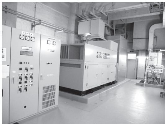
公共下水道浄化センター 625kVA非常用ガスタービン発電装置
