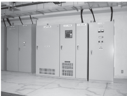
デジタルテレビ放送所 無停電電源装置 (30kVA)
