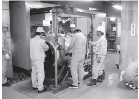
金融機関事務センター 1,250kVAガスタービンのオーバーホール
