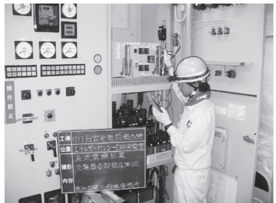
自家発電設備の点検作業
