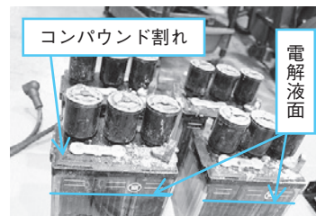
写真15 蓄電池のコンパウンド割れ、電解液面低下の状況
