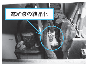
写真16 蓄電池の電解液の結晶化の状況
