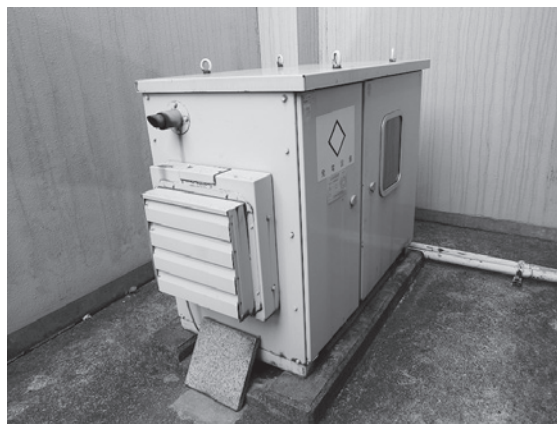
写真1 発電設備の設置状況
