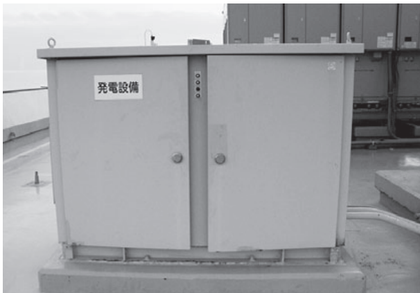
図1 発電設備の設置状況
