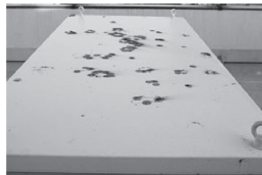
図6 天井板の発生状況
