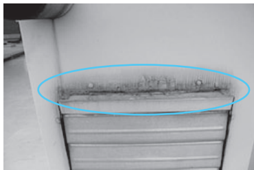
図4 左側面シャッター取付部の発生状況
