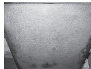
図10 燃料タンクの錆を除去した状況 （外部底面）
