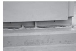
図2 アンカーボルト及びチャンネルベース
