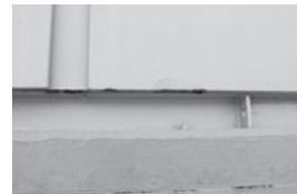
図3 扉下部の発生状況
