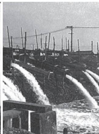
ポンプを提供した排水機場
