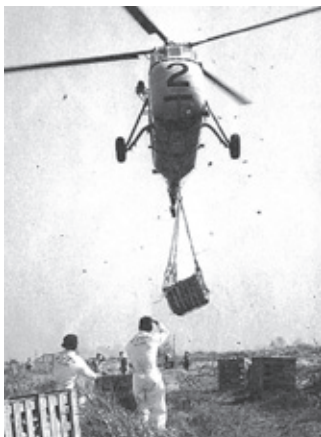
伊勢湾台風での復旧作業
