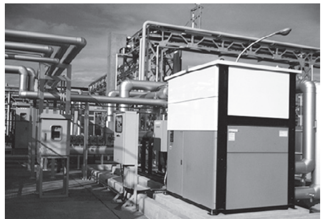
廃温水蒸気発生装置
