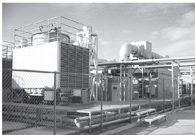
相模原工場第五発電所の発電装置
