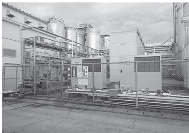
図8 バイオガス発電機設置状況
