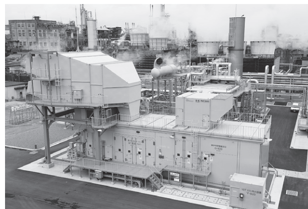
図8 3万kW級コージェネレーション
