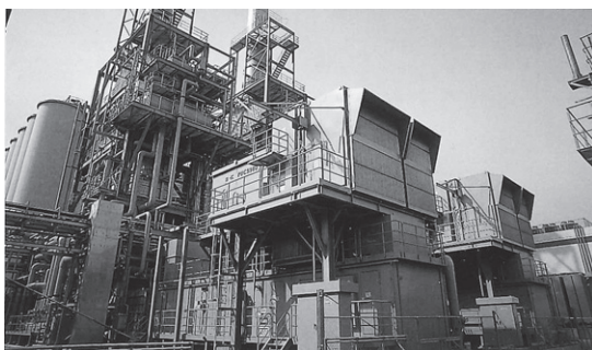
図6 5万kW級コンバインドサイクル発電設備
