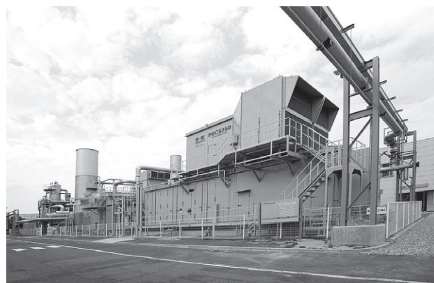
図9 明石工場エネルギーセンター
