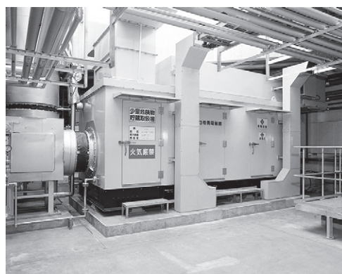
図1 非常用兼用デュアルフューエルコージェネレーション
