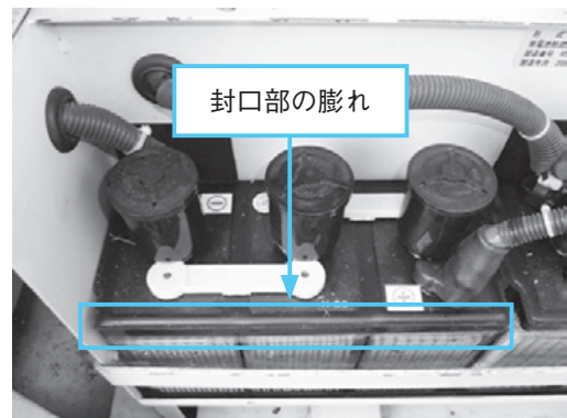
写真15 蓄電池の封口部膨れ
