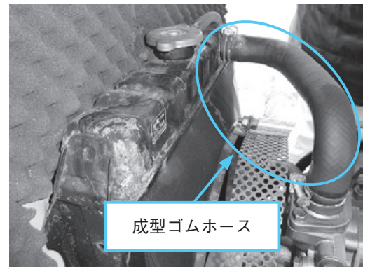
写真18 冷却水ゴムホースの変形
