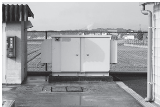
写真1 設備の全体写真
