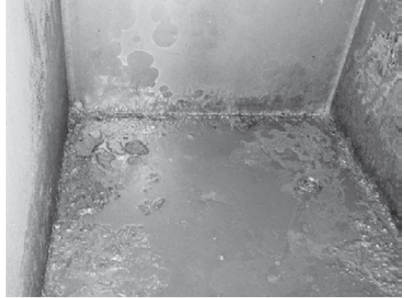
写真23：燃料容器の内部
