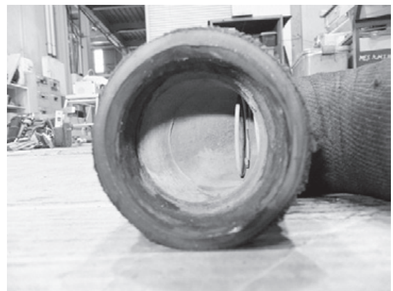
写真30：冷却水ゴムホース内部
