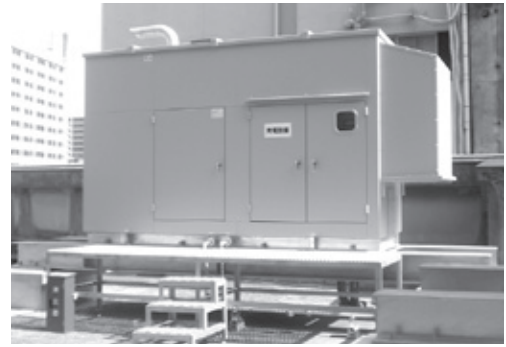
銀行へ納めた非常用ディーゼル発電設備
