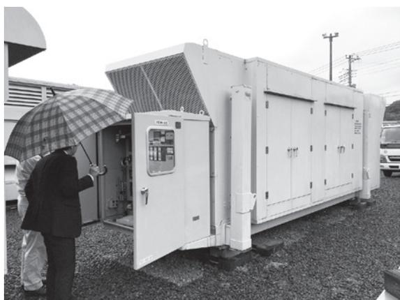
自揚型移動式高圧発電装置（6,600V、60Hz 625kVA）
