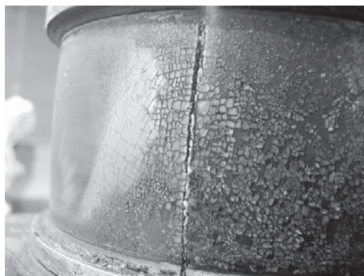
写真4：防振ゴム亀裂（剥離）
