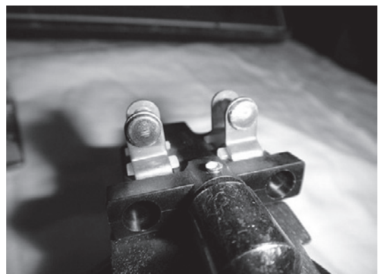
写真11：電磁接触器 変色
