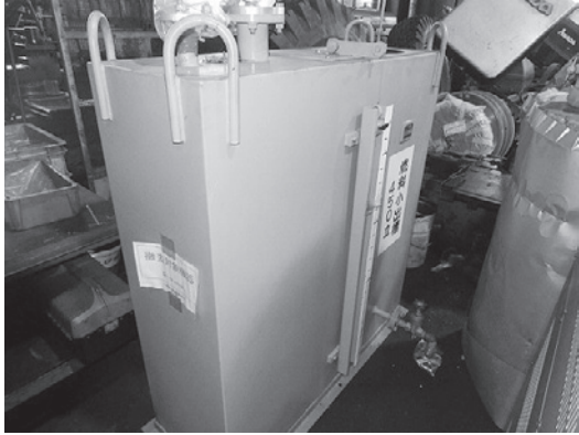
写真13：燃料小出槽 外観
