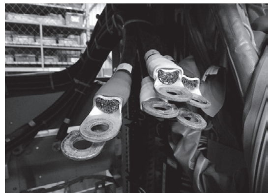
写真17：主回路ケーブル
