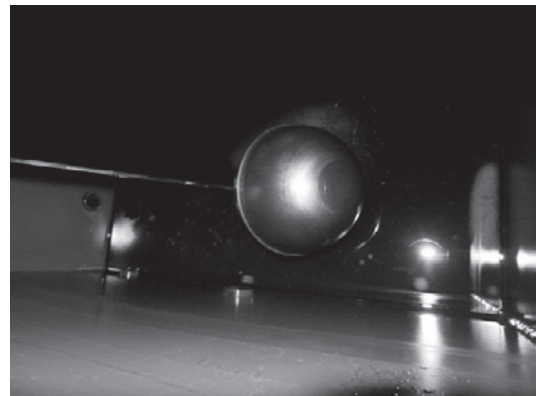
写真16：潤滑油補給槽 内部状況
