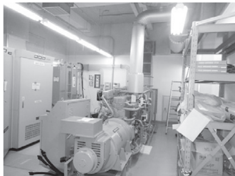
写真1：設備の全体写真
