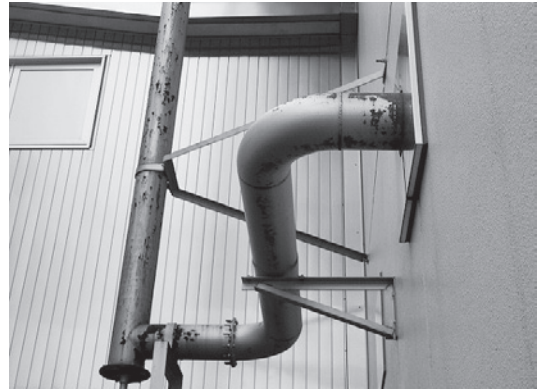
写真19：屋外排気管 一部腐食
