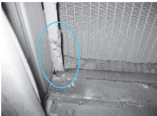
写真8：ラジエータ排気フード フレーム部塗装剥れ
