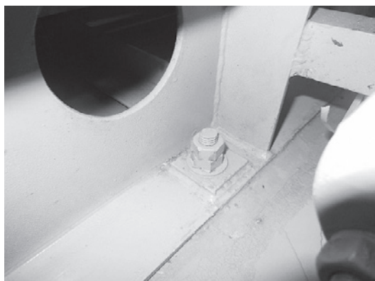
写真3：原動機アンカーボルト
