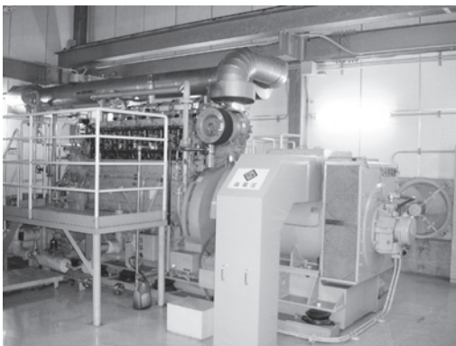
御蔵島の発電設備
